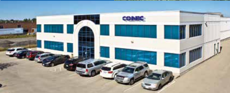
CONEC Canada, Brampton
